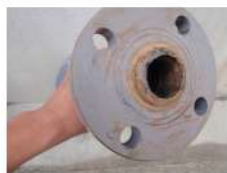
洗浄前の配管内
